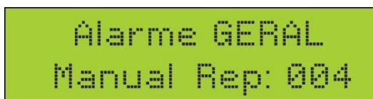
Figura 3. 10: Alarme geral manual no repetidor 4.
